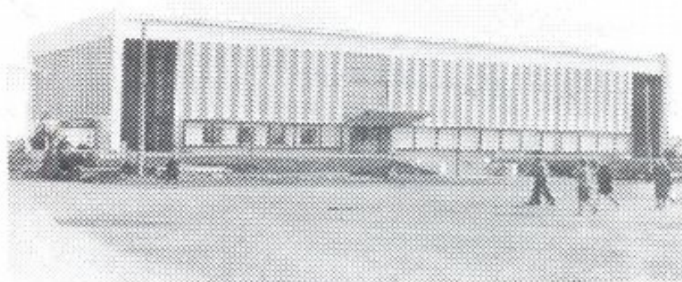
Строительство кинотеатра «Победа». 1960-е годы
