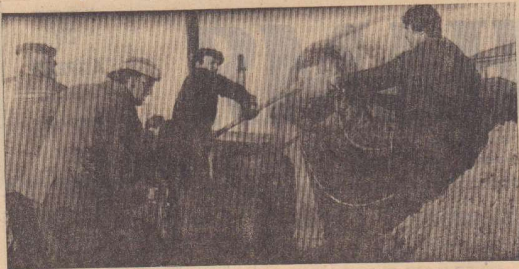
Организованно, с высокой производительностью прошел праздник коммунистического труда в механосборочном цехе № 58 Омского телезавода. Сразу же после митинга закипела работа на строительных площадках и на участках. На закладке фундамента под новые объекты.
